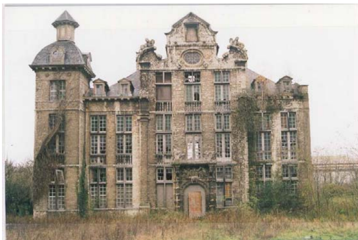
Voorgevel oorspronkelijke toestand
