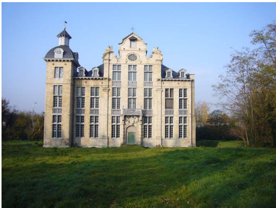
Voorgevel huidige toestand
